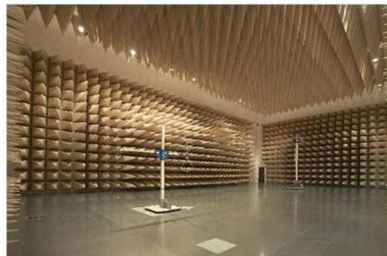
10m 法対応電波暗室
