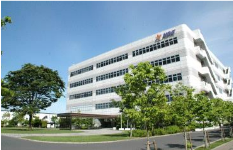
日本電波工業(株) 狭山事業所
