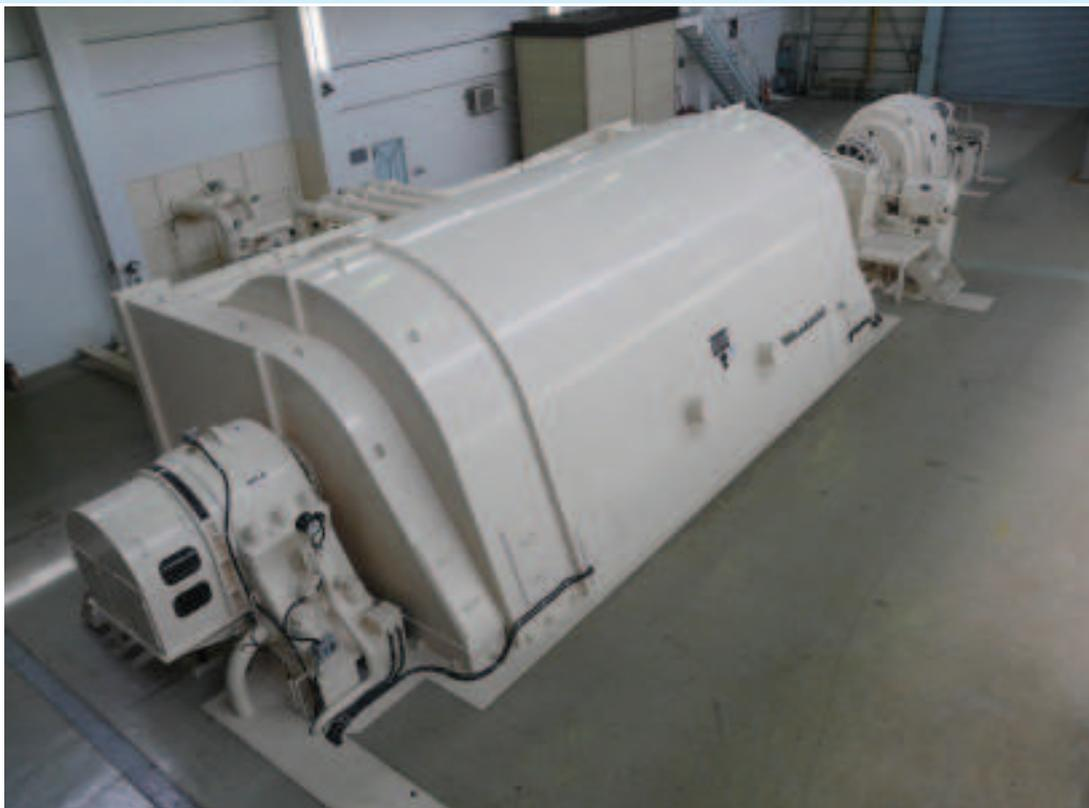
短絡発電機（電圧：15kV、短絡容量：2500MVA、50/60Hz）
